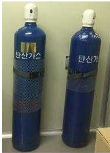
그림 11-3-2. 가스용기 전도 방지 장치
