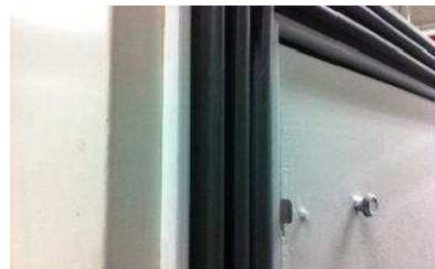
그림 9-29. 얼음제거 후 개스킷 상태
