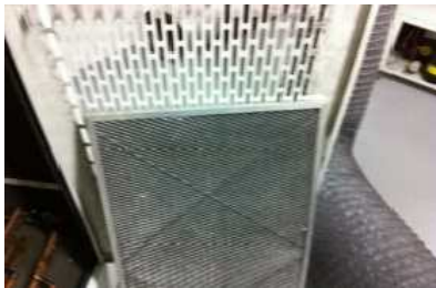
그림 4-10. 에어필터 제거 모습
