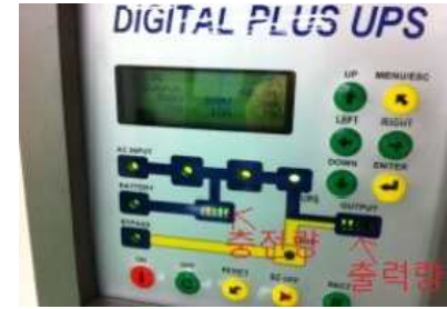
그림 5-7. 컨트롤러 출력과 충전량 표시
