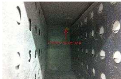
그림 9-11. 티-니플 부적합 장착 상태
