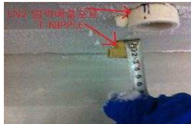
그림 9-7. 티-니플 설치 적합 상태
