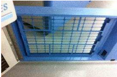
그림 9-76. 에어필터 제거 상태
