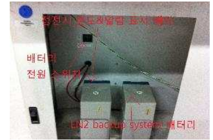
그림 9-66. 배터리 설치 상태
