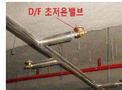
그림 9-92. 기계식냉동고용 초저온밸브
