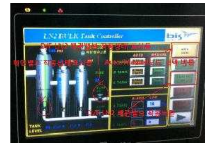
그림 9-93. 액체질소 공급 관리 시스템
