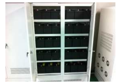
그림 5-2. 캐비닛 내부 배터리
