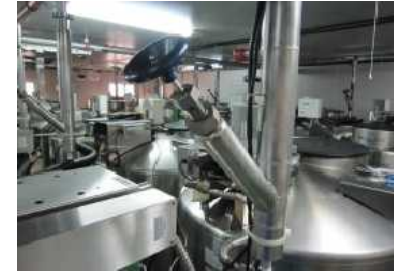
그림 8-19. 진공밸브 열림 상태
