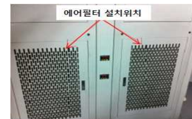
그림 4-6. 에어필터 설치 위치
