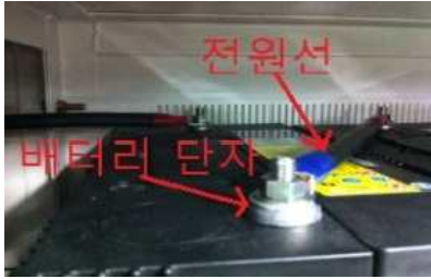
그림 5-3. 배터리 단자와 전원선
