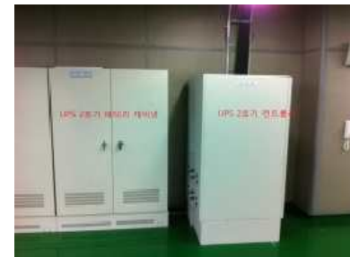
그림 5-1. 컨트롤러와 배터리 캐비닛
